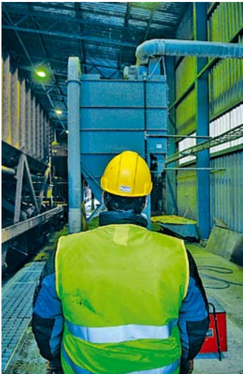
Vastaanottosiilossa ja kuljettimissa ovat pölyn poistoon tehokkaat imurit.
